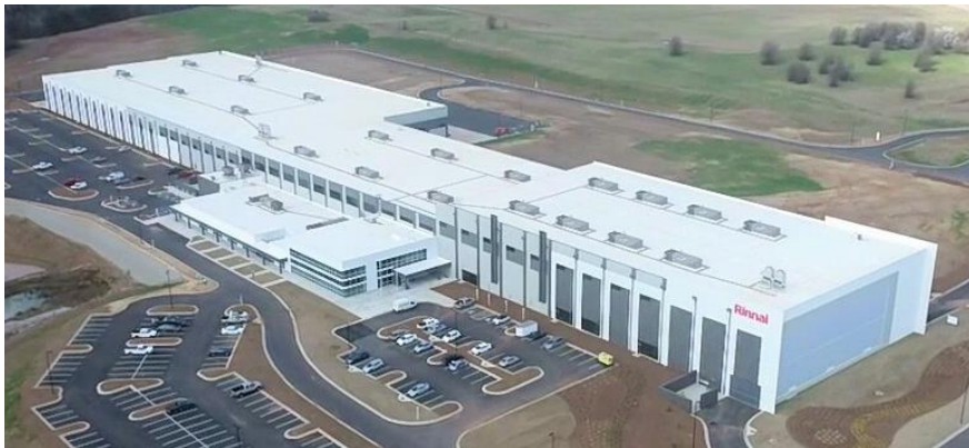
グリフィン工場 外観
