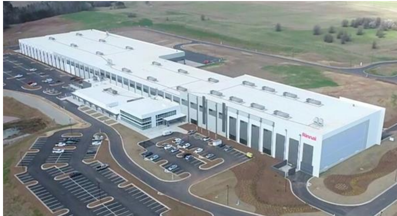
グリフィン工場 外観
