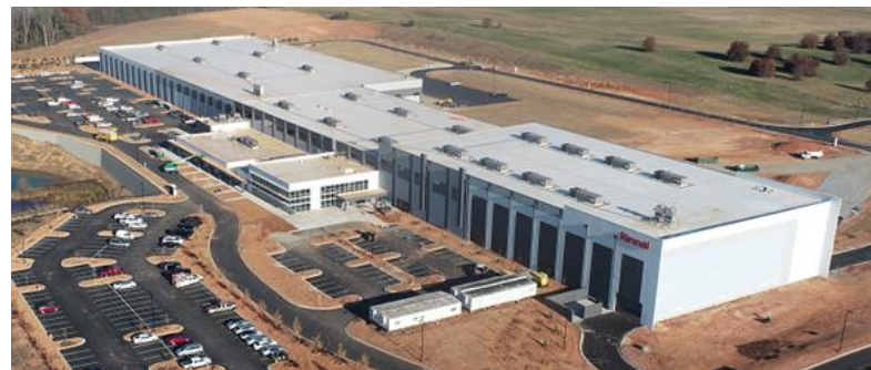
グリフィン工場 外観
