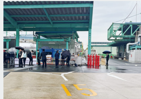
会場となった知多水素ステーション
