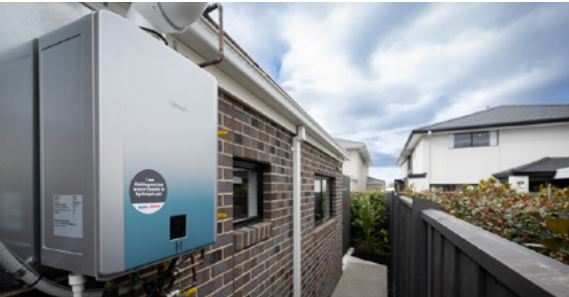
水素100%燃焼給湯器の実証実験 (オーストラリア「水素の家」)
