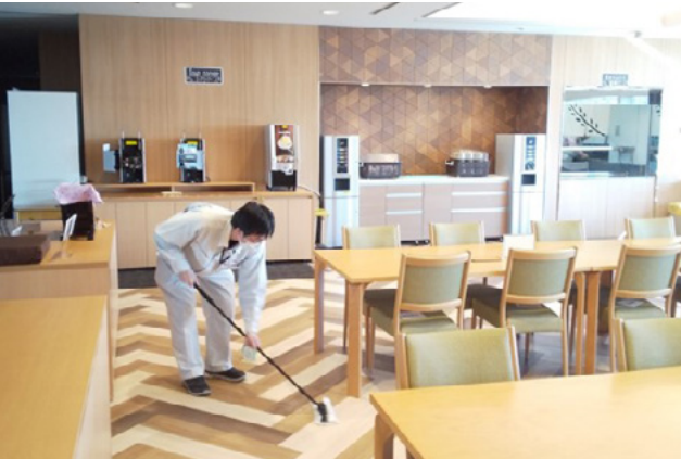
本社ビルの清掃作業
