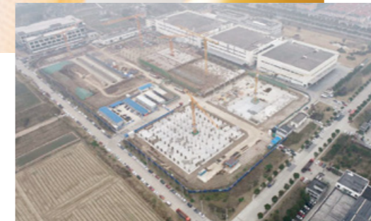
上海林内の工場増設
