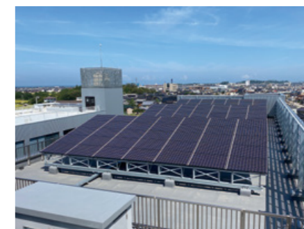
太陽光発電パネルの自社設置
