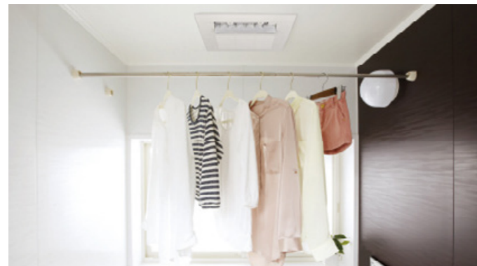
浴室暖房乾燥機
