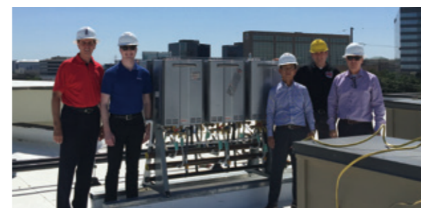
連結給湯器を導入
