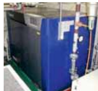
インバーター制御式コンプレッサー
