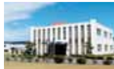
4 リンナイテクニカ(株) 静岡県掛川市
