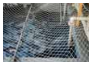
水槽転落防止
