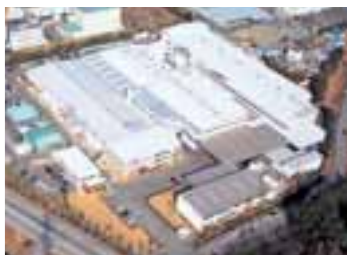
瀬戸工場 愛知県瀬戸市
