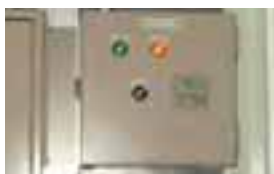
新たに制御盤を設置
