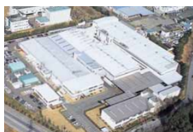
瀬戸工場 愛知県瀬戸市
