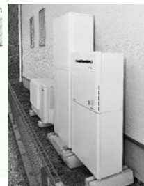
タンクユニット・ガス給湯器 分離設置イメージ
